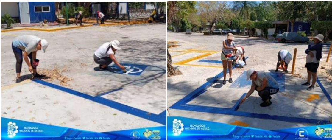
Pintura en cajones de estacionamiento y rampas para personas con discapacidad.
