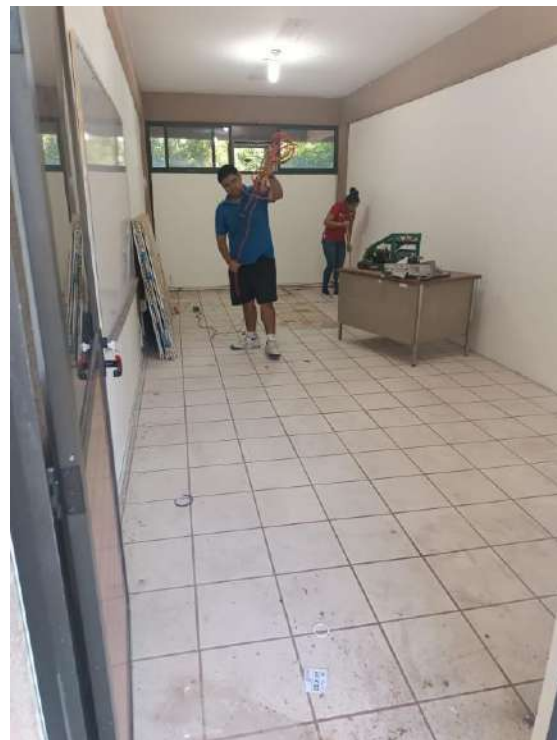
Adaptación del aula C6, incluyendo la colocación de piso de loseta
